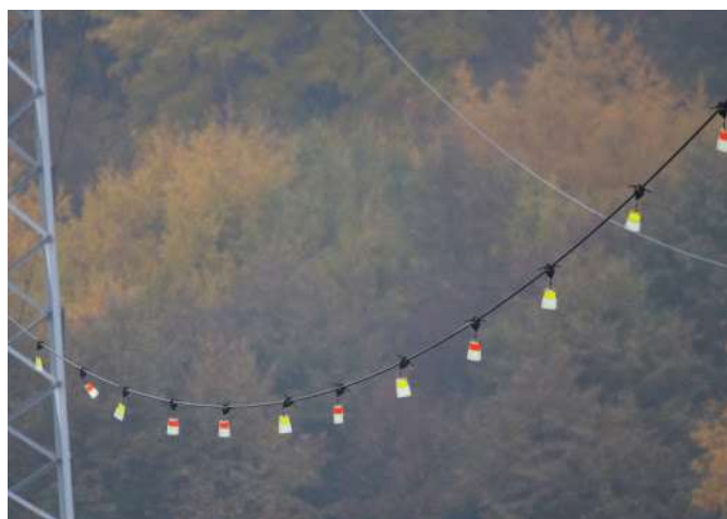
Figura nr.7. 9 Exemple de semnalizatoare fixate pe linii de înaltă tensiune
