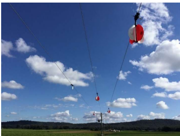
Figura nr.7. 9 Exemple de semnalizatoare fixate pe linii de înaltă tensiune
