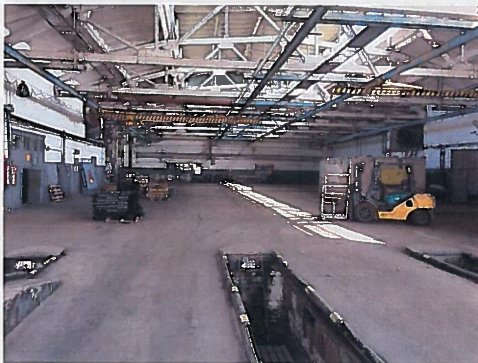
Figura 14: Garajul ÎS Moldelectrica
